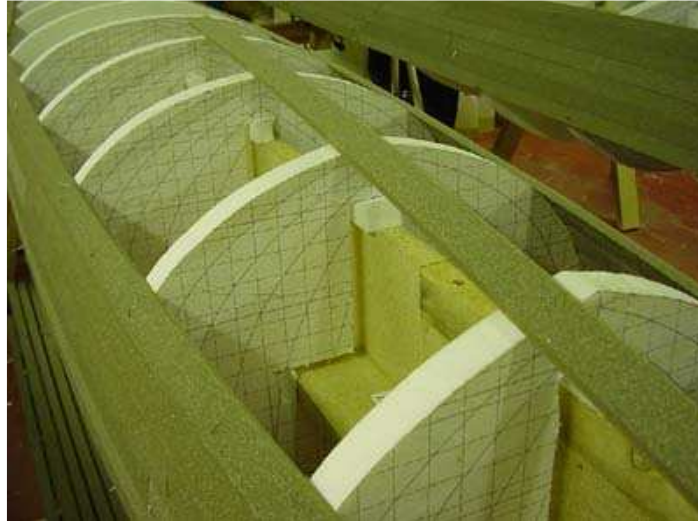
Figur 2. Strimlor av kärnmaterialet sätts fast vid frigolitskivorna[1]
